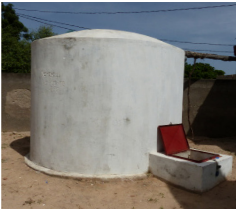
Récupérateur d'eau de pluie de 10m 3 (Première étape dans le cadre de la rénovation du Poste de santé initiée en Juin 2013,
