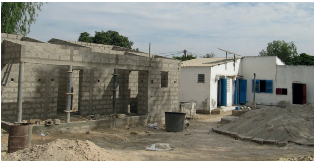
Construction du bâtiment de médecine générale
