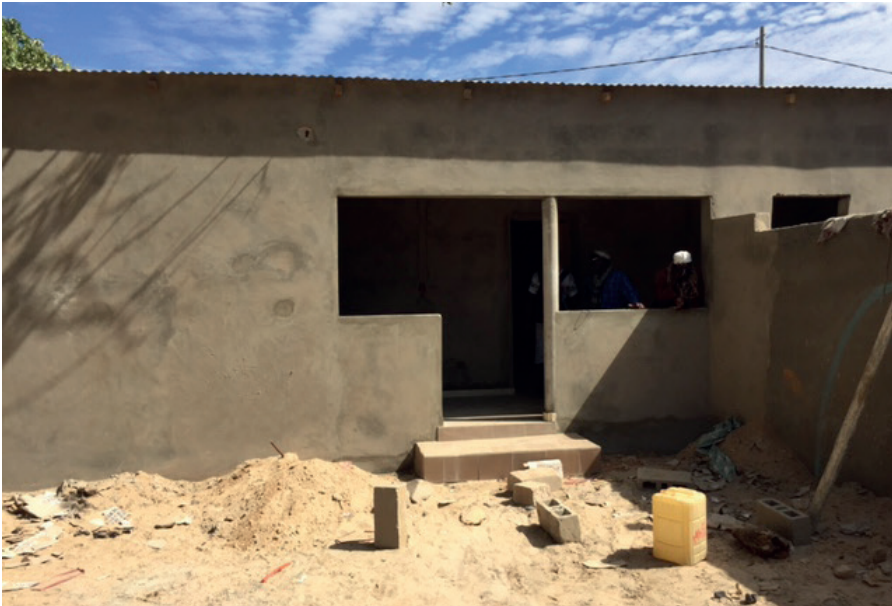
Le bâtiment de médecine générale est enduit, le carrelage posé, les cables sont passés, les huisseries intérieures et extérieures sont posées. Le cablage électrique est terminé.
