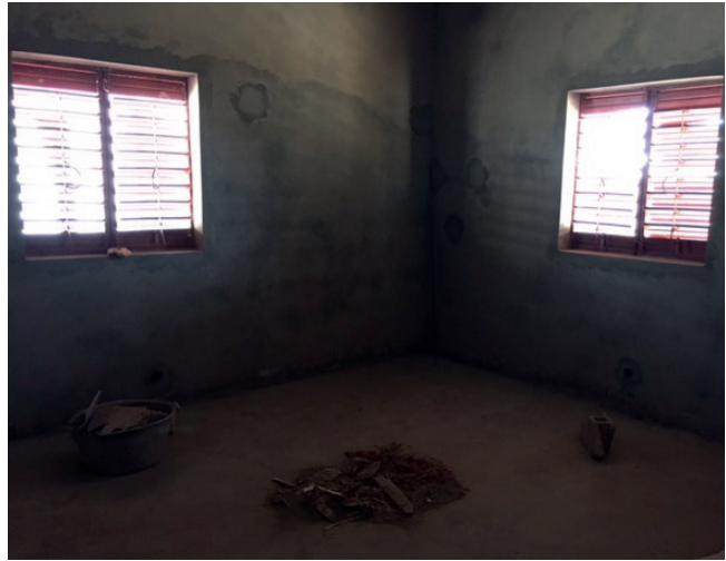
Le bâtiment de médecine générale est enduit, le carrelage posé, les cables sont passés, les huisseries intérieures et extérieures sont posées. Le cablage électrique est terminé.
