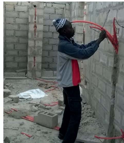
Pose des gaines électriques
