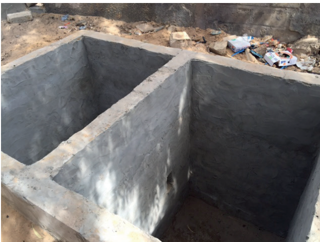
Le logement de la sage femme Construction terminée, la toiture posée, Enduits extérieurs et intérieurs réalisés. Carrelage et les huisseries intérieures posés. Fosses d'assainissement terminées. Mur d'enceinte construit et enduit.
